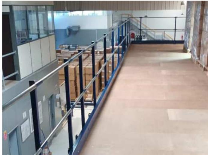
peut s'étendre sur plusieurs niveaux (1, 2 ou 3 étages), offrant ainsi un espace de stockage supplémentaire ou des zones de préparation de commandes sans empiéter sur la surface au sol. Le montage est rapide et simple, parfaitement adapté aux besoins
