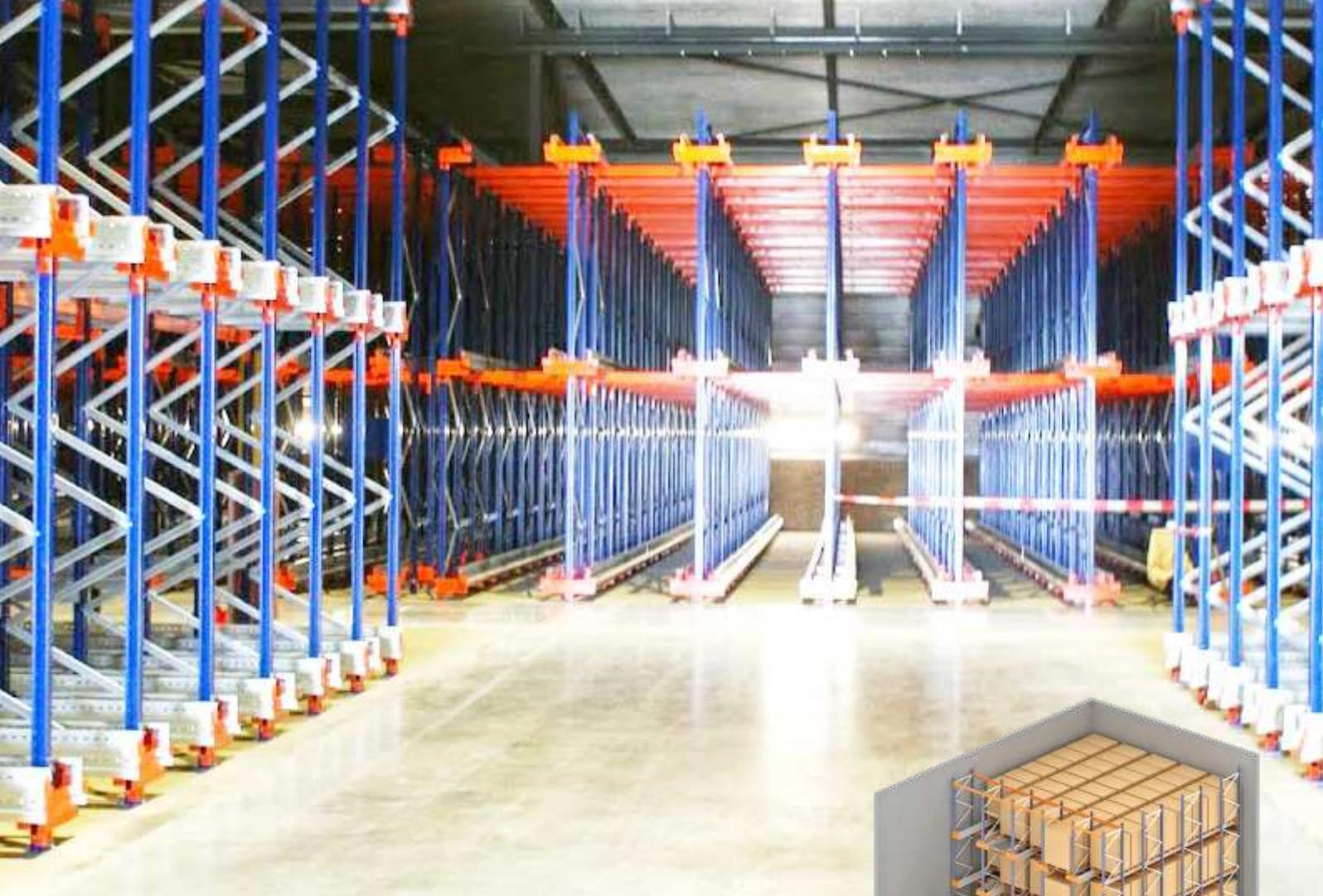
une utilisation maximale de l'espace disponible grâce à son principe d'accumulation, où les produits sont stockés par lot. Ce système offre un stockage dense et sécurisé, facilitant un processus de gestion simplifié et rapide des stocks.
